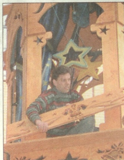
Die vorgefertigten Balkon-Elemente werden von Ralph Landwermann eingepasst.
